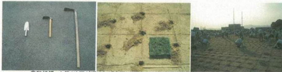
②移植鍬、小鍬(地面が硬ければ唐鍬)で深さ5cm程度の穴を掘る
